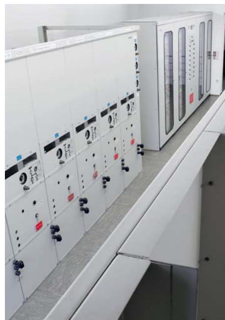
Первое распределительное устройство 8DA10 с элегазовой изоляцией для первичных распределительных уровней – BELG (сегодня E.ON Bayern AG), Станция Kulmbach Mitte, Германия
