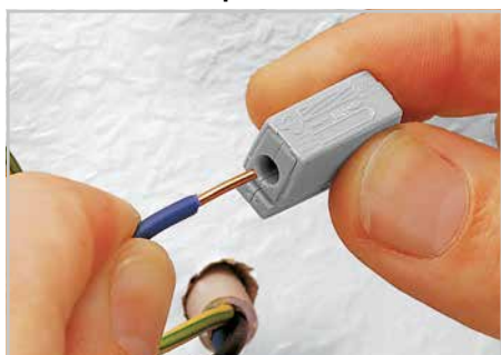
Сторона монтажа: вставьте зачищенный однопроводный проводник в круглое отверстие до упора.
