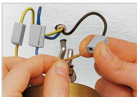
Сторона осветительной арматуры: нажмите до упора кнопку, введите в прямоугольное отверстие конец зачищенного проводника и отпустите его.
