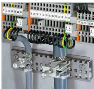
Установка на несущую рейку со специальной перфорацией
