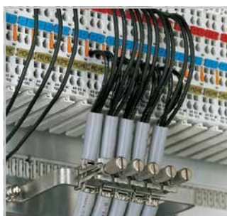
Установка на U-образной медной силовой шине
