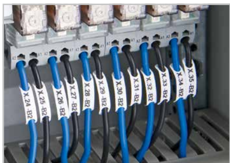
Маркеры с отверстиями для продевания проводника
