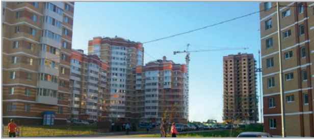
Жилой микрорайон объект Космодром "Восточный" Амурская область
