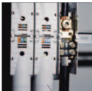
Соединение медных и алюминиевых проводников
