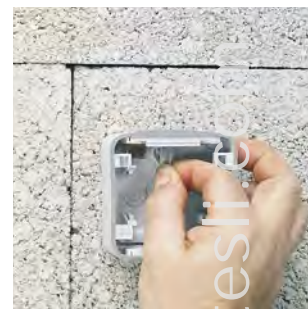
Вручную удалите центральную часть мембраны на торцевой заглушке, потянув за язычок
