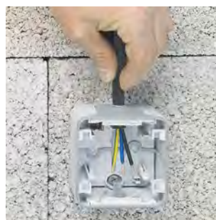
Мембрана на торцевой заглушке обеспечивает степень защиты IP55
