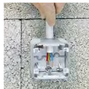
Мембрана торцевой заглушки компенсирует любое отклонение трубки от вертикали и обеспечивает степень защиты IP55
