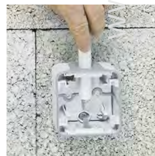
Вставьте трубку в торцевую заглушку
