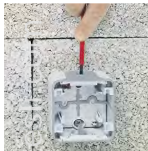
Сделайте отверстие в торцевой заглушке при помощи отвертки
