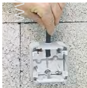
Вставьте кабель в торцевую заглушку
